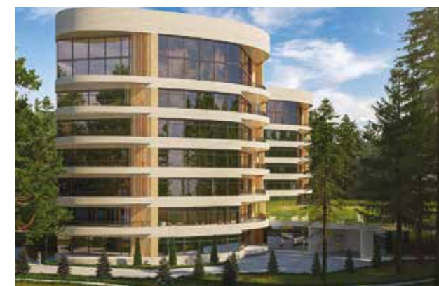
ЖК «Флора и Фауна» г. Новосибирск, 2018-2019 г.г.
