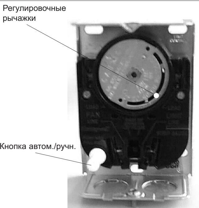
Рис. 9.4 Битермостат "Fan-limit"
