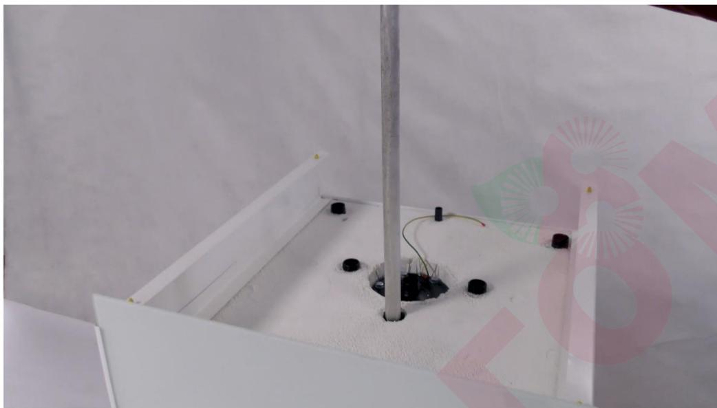
Процедура замены магниевого анода. Перед тем как заменить магниевый анод, перекройте подпитку холодной воды, спустите давление в баке и только после этого, убедившись что все порядок, выкручивайте анод. Требования по замене магниевого анода описаны в инструкции по монтажу и эксплуатации баков.
