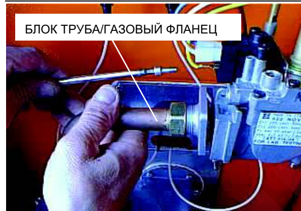
Рисунок 35 – Блок труба/газовый фланец
