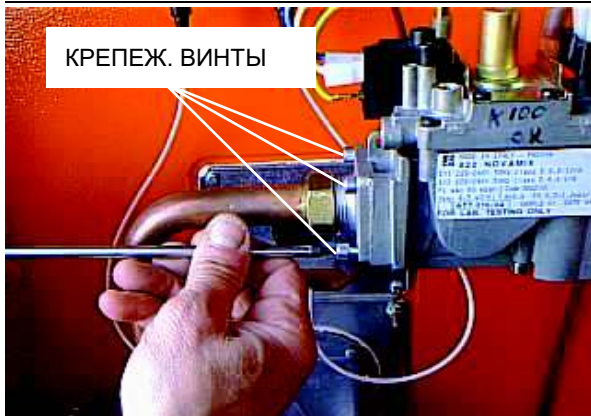
Рисунок 34 – Крепежные винты газового фланца
