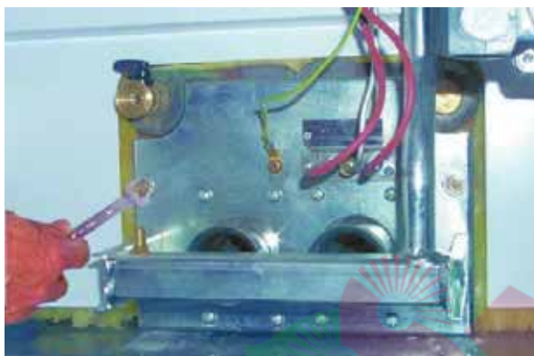
рис. 22 - Демонтаж горелок
