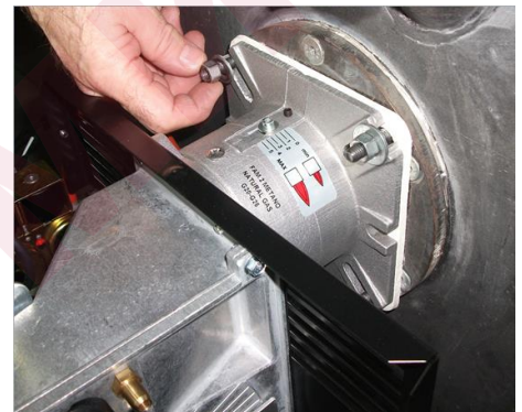
6) Зафиксировать горелки на котел;
