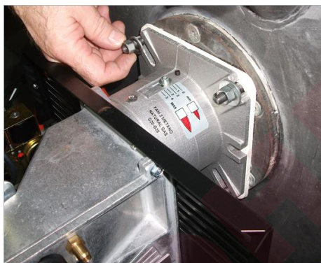
7) Зафиксировать горелки на котел;
