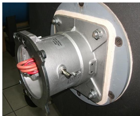
2) Смонтировать Смесительную Группу на котле;
