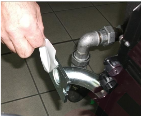
7) Снять заглушку из Труба ГАЗОВОЙ рампы;
