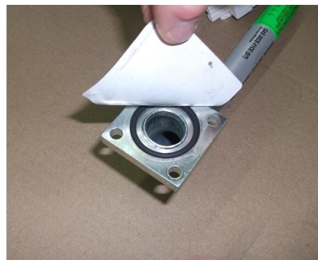
3) Снять заглушку из Труба ГАЗОВОЙ ramпы и удостовериться, что прокладка фланца ramпы установлена в правильном положении;
