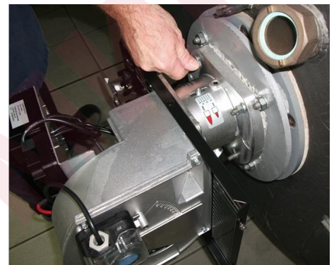
6) Зафиксировать горелки на котел;
