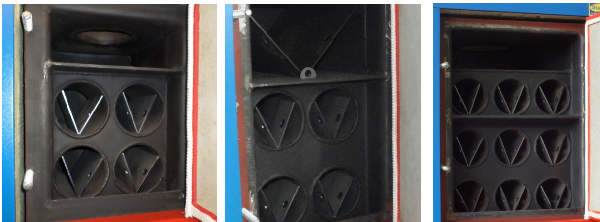
Рисунок 4 – Схема установки турбулизаторов
